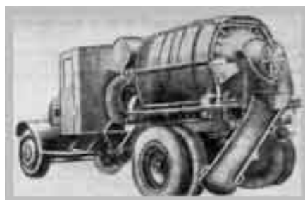
Фиг. 2. Автобетоносмесител СССР (1938)
